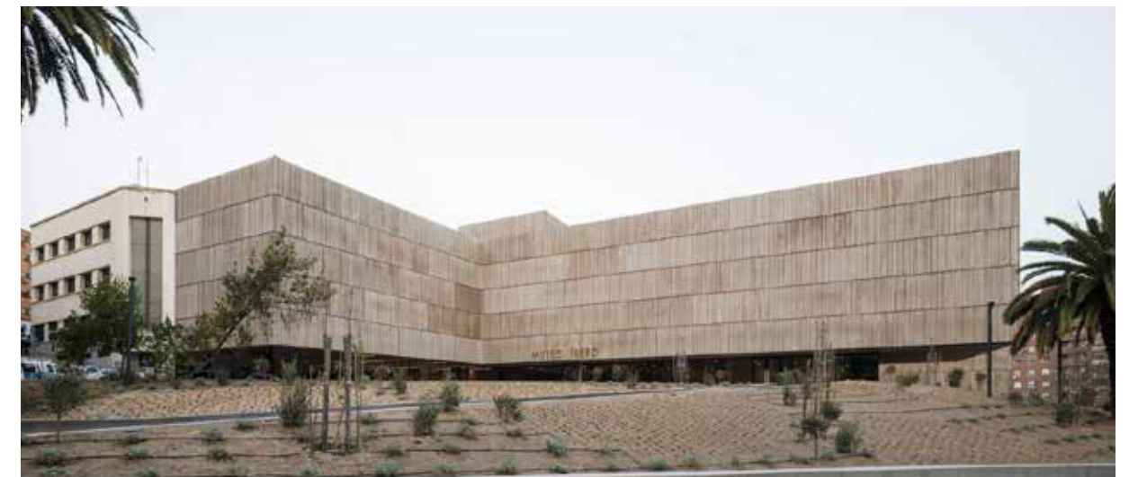
↑ IMG_47: Fotografía tomada desde la calle hacia el proyecto. «Museo ÍBERO» © Fernando Alda Recuperado de https://www.plataformaarquitectura.cl/cl/885532/museo-ibero-jl-lopez-de-lemus-harald-schonegger-ignacio-laguillo-luis-ybarra
