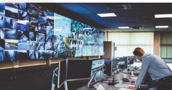
Figura D37 Centro de monitoreo y vigilancia
