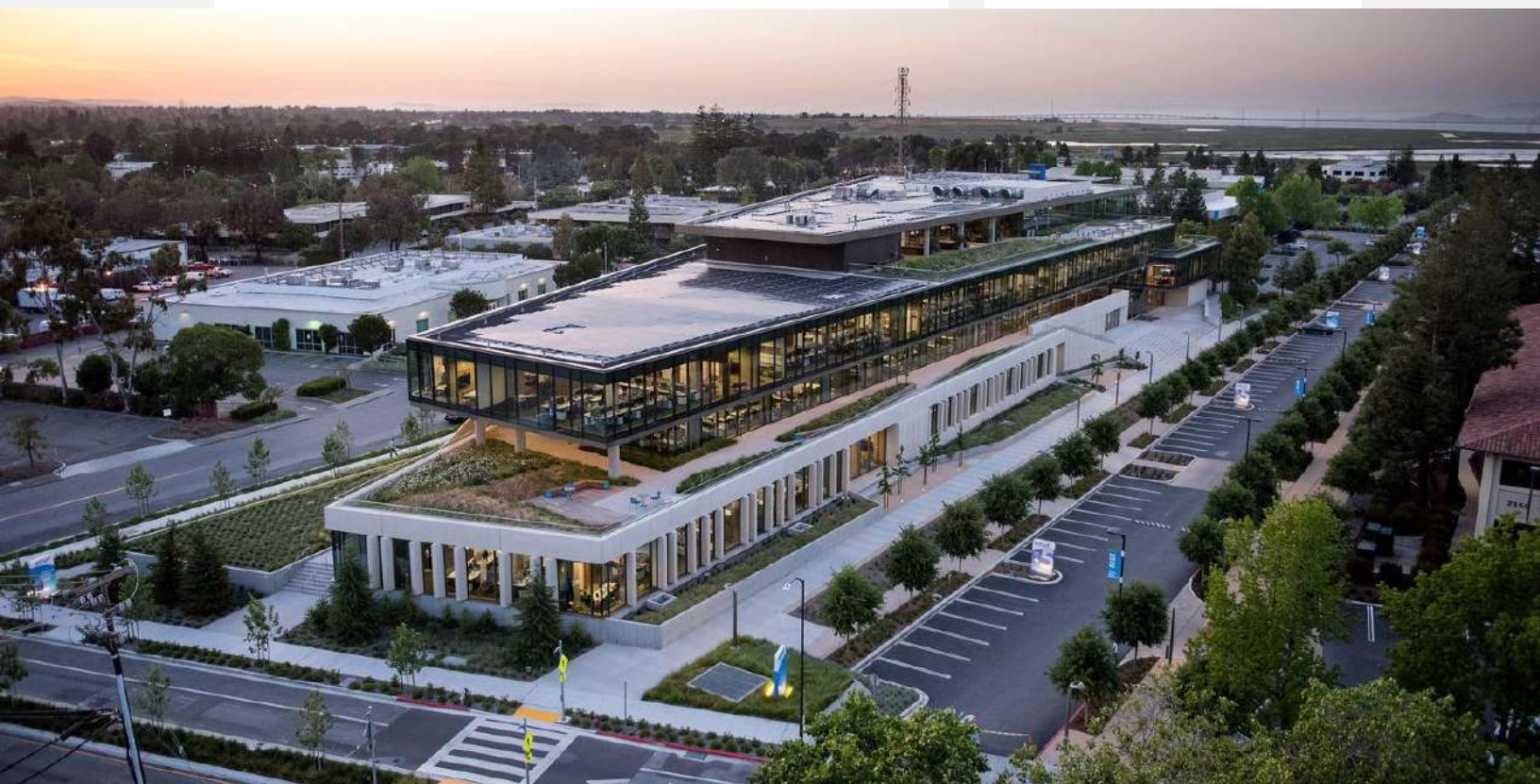
Figura A11 Vista aérea del Edificio Intuit Marine Way
