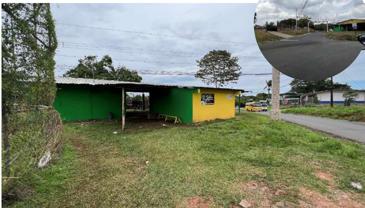
Imagen 21 Vista de la casa comunal y la escuela desde la entrada de la cancha de softbol
