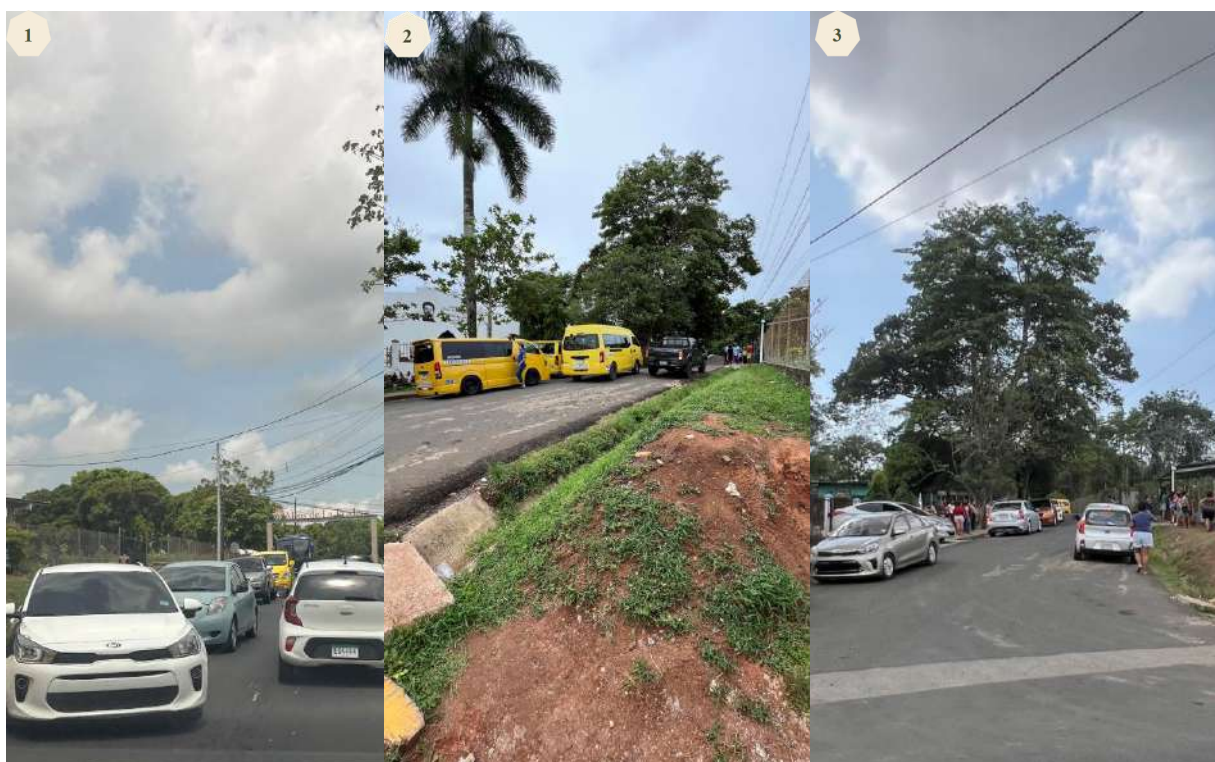
Imagen 13 Estado actual del área de espera
