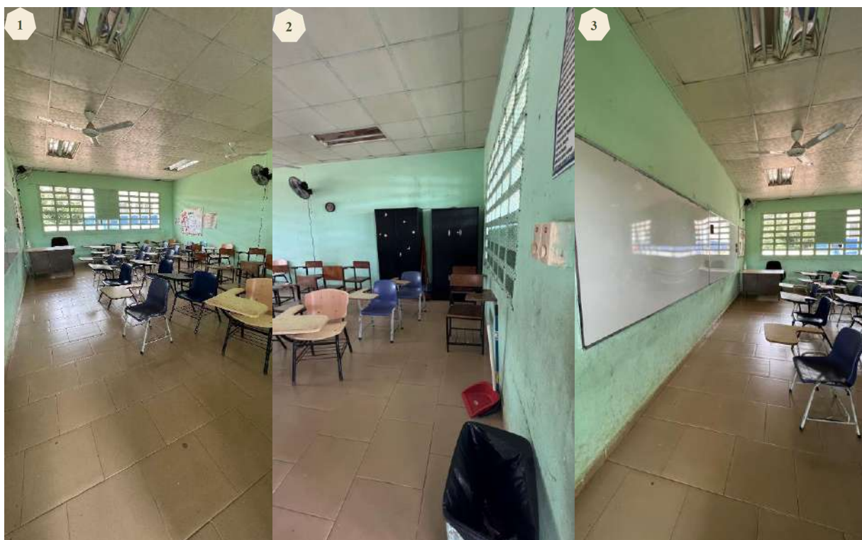
Imagen 15 Estado actual de las aulas de clase
