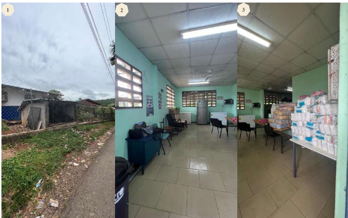
Imagen 17 Estado actual del área de servicio.
