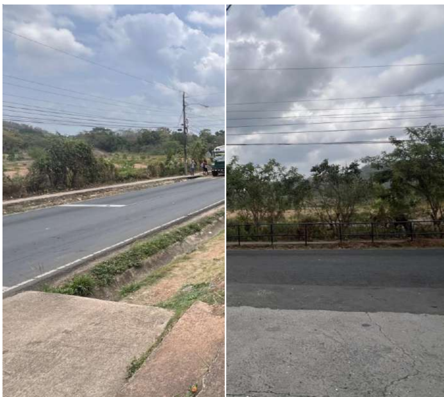
Imagen 26 Vistas del Terreno No. 3
