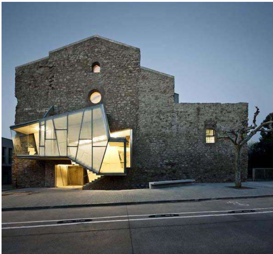
Imagen N.º13 Fachada frontal del Convento de Sant Francesc
