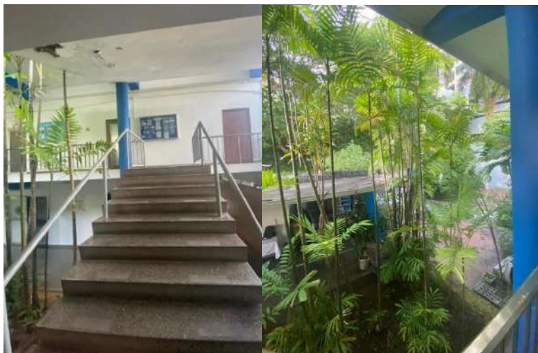
Imagen N.º41 Edificio ateneo, área verde y accesos a los niveles. Fuente: Autoría propia
