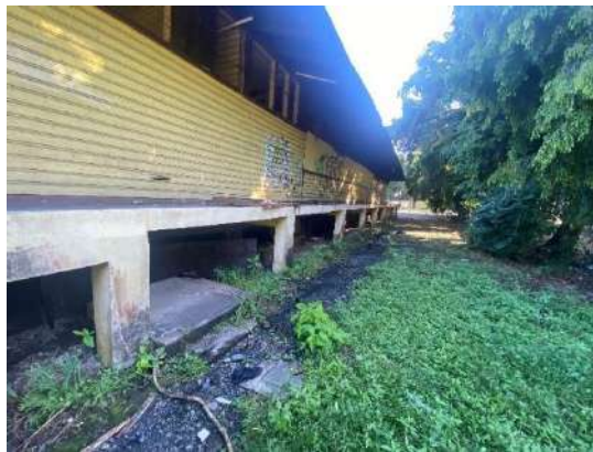
Imagen N.º67 Fachada Oeste, ala de servicio.
