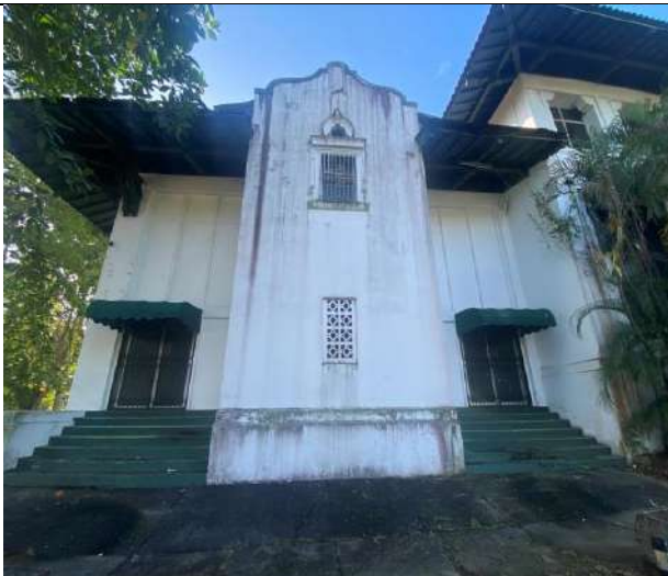
Imagen N.º55 Fachada Frontal, del área del auditorio.
