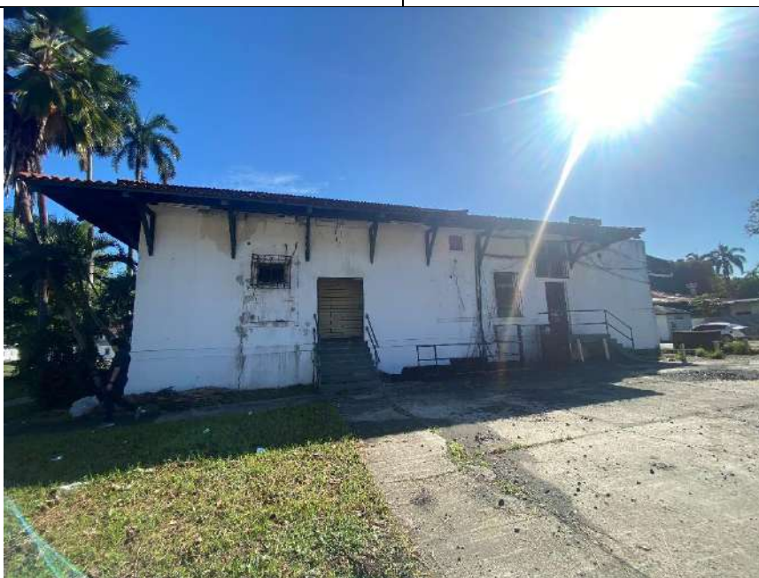
Imagen N.º65 Fachada Oeste, ala de servicio
