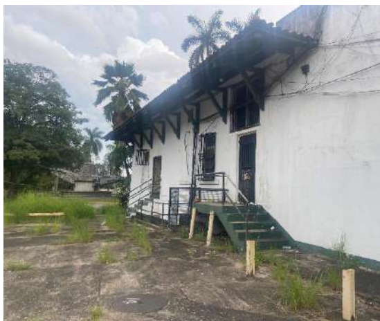
Imagen N.º64 Fachada Oeste, ala de servicio.
