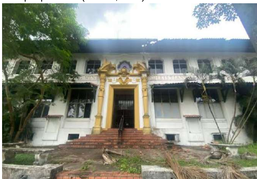
Imagen N.º47 Foto actual del Edificio Y.M.C.A. Fuente: Autoría propia
