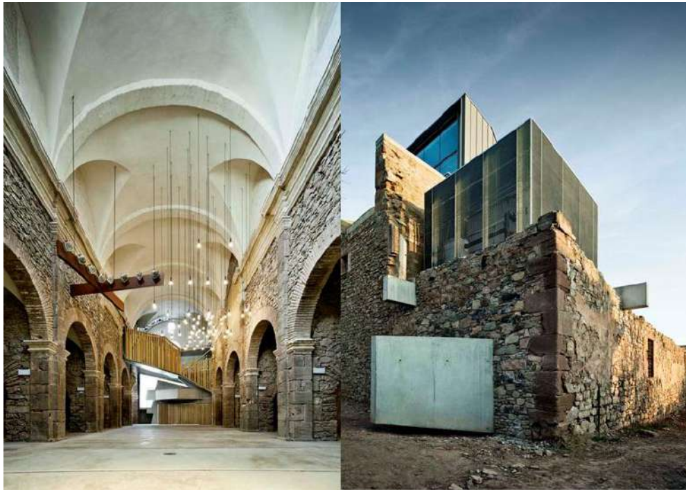
Imagen N.º14 Exterior e interior de las intervenciones que se realizaron en la iglesia.
