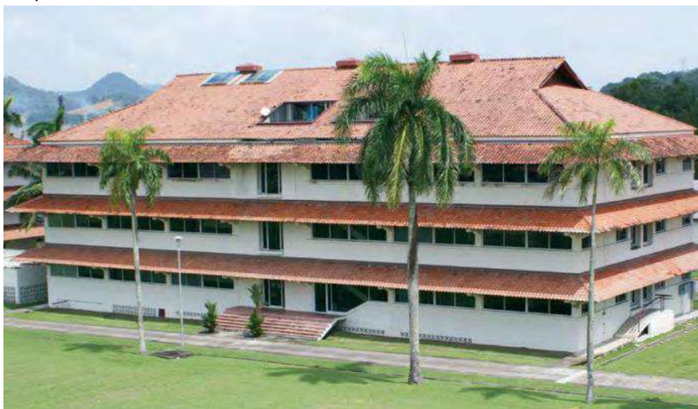
Imagen N.º73 El edificio 102, una de las antiguas barracas del Cuadrángulo Central, rehabilitado en 2002 para las oficinas regionales de UNICEF.
