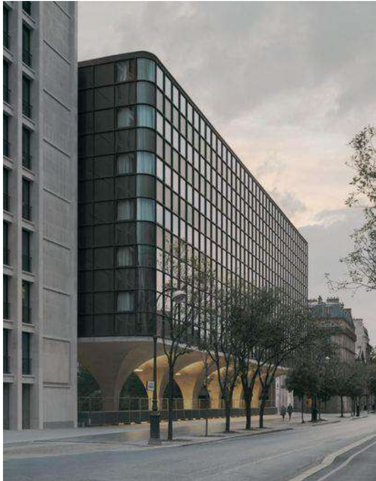
Imagen N.º12 Fachada de la intervención del Museo Fuente: Fotos tomadas por Simón Menges. (Pintos, 2022)
