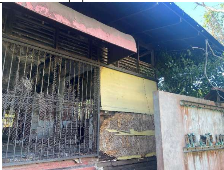
Imagen N.º71 Gimnasio estado actual Fuente: Autoría propia
