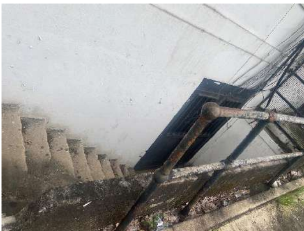
Imagen N.º63 Fachada Oeste, cuarto de basura.
