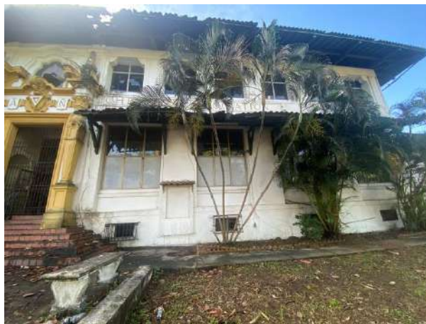
Imagen N.º51 Fachada Frontal del Edificio Y.M.C.A.
