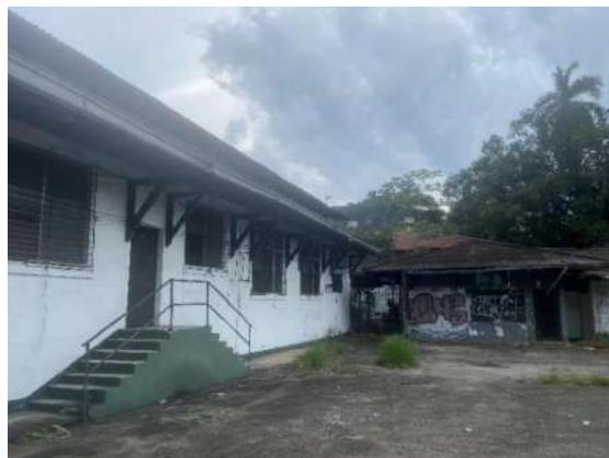
Imagen N.º62 Fachada Sur, Edificio principal y el ala de servicio, patio interno.
