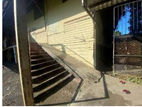
Imagen N.º66 Fachada Oeste, ala de servicio.
