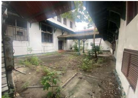
Imagen N.º61 Fachada Sur, Edificio principal y el ala de servicio, patio interno
