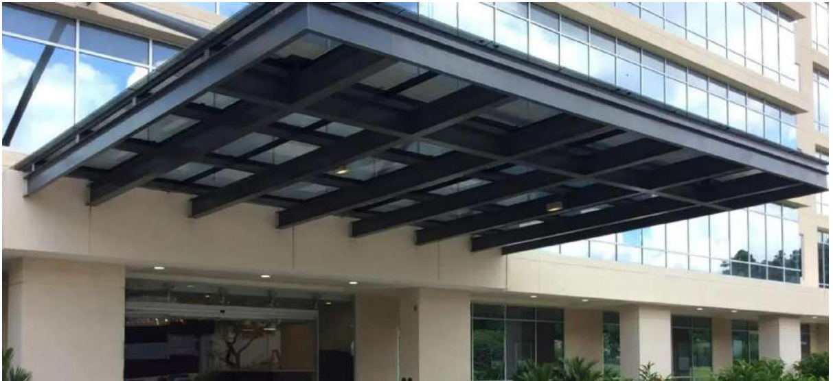
Imagen N.º101 Pérgola con vidrio fotovoltaicos de Onxy Solar en Panamá Pacífico
