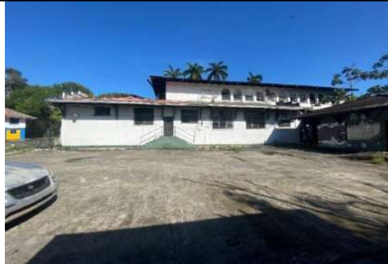
Imagen N.º60 Fachada Sur, Edificio principal y el ala de servicio.
