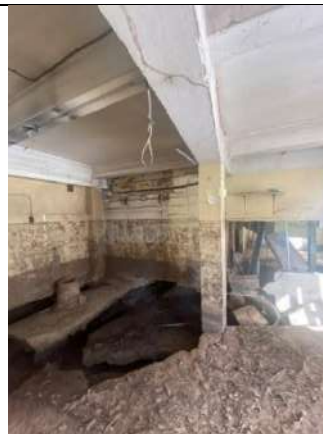
Imagen N.º59 Fachada Este, cuarto del nivel inferior.
