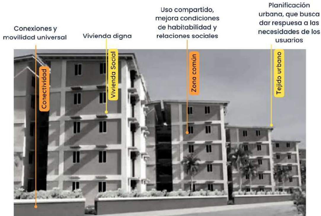
Figura 28. Estudio de caso: Vivienda social tipo cáscara en Colón. Imagen de MIVIOT (2016). Proyecto habitacional Altos de Los Lagos. Elaboración propia.
