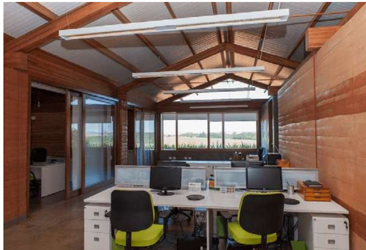
Figura 35. Uso de materiales locales como el Taipa Pilón para un proceso constructivo, implementando el uso de una formaleta y tierra compactada, mezclada con cal. Fotografía de grupo Taipal Brasil, A Construção com Terra é Biofílica, 2022
