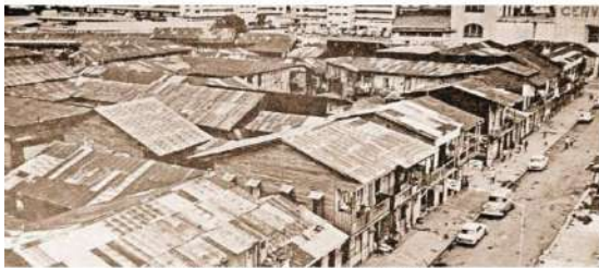
Vivienda de madera en Curundú, 1980 En la construcción de viviendas de madera y zinc en la capital.
