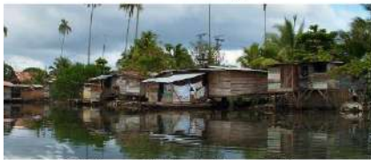
Palafitos en Almirante Bocas del Toro En la construcción de palafitos utilizan madera.
