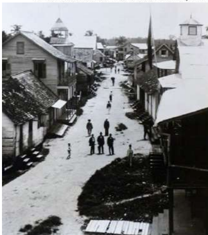
Vivienda de madera en Bocas del toro En la construcción de viviendas de madera y zinc.
