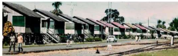
Vivienda de madera en poblado en Bocas del Toro Barrios prefabricados construidos con madera.
