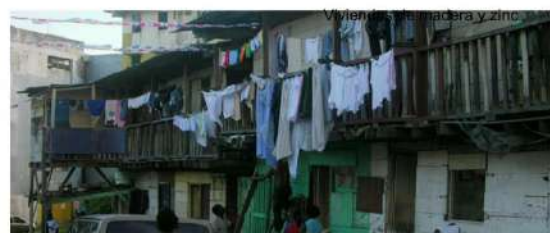
Vivienda de madera en Curundú 2014
