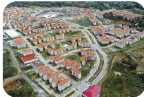
Vistas general del conjunto de Altos de Los Lagos
