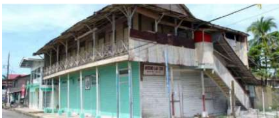
Viviendas de madera y zinc
