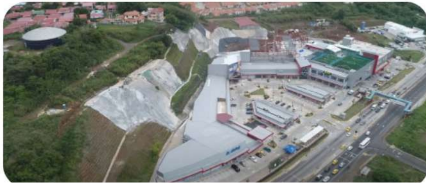
Figura 61. Vistas de la altura en Ancas Mall. Fuente: PTY Drone Adventure
