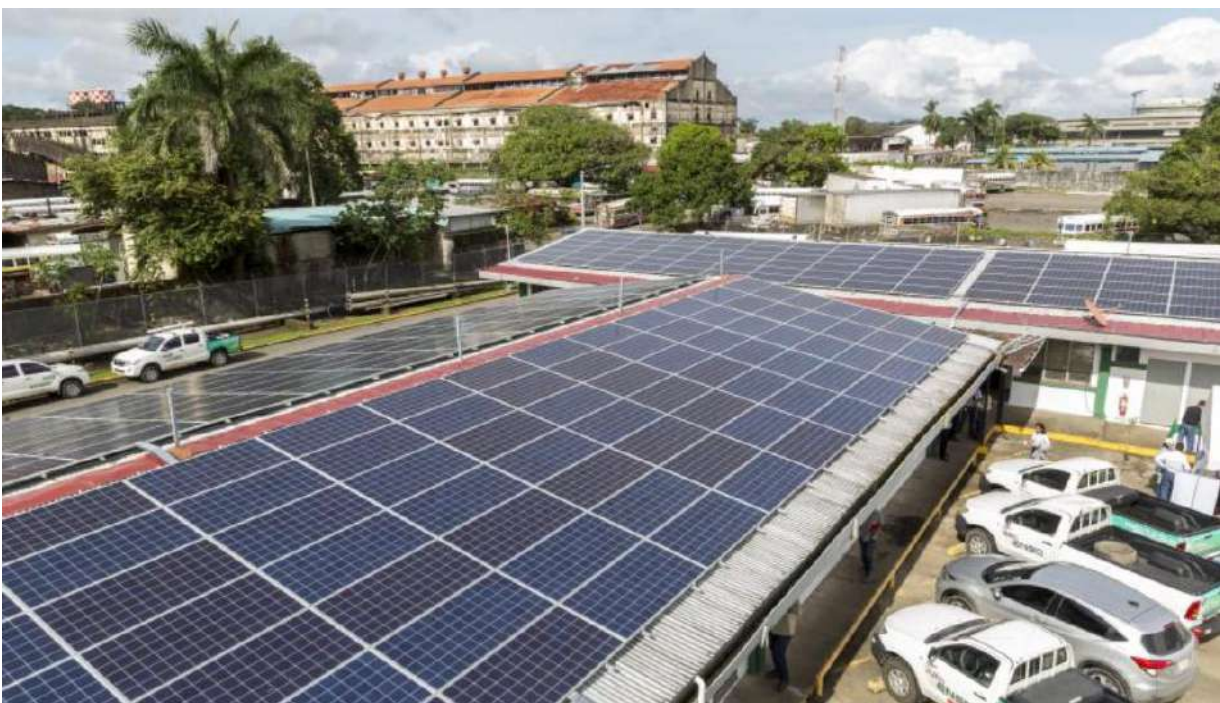
Fig. 23. Instalación de paneles solares 2. https://www.ensa.com.pa/noticias/ensa-promueve-la-energia-solar
