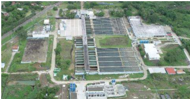
Fig. 20. Planta potabilizadora de Chepo. Vista aérea. @idaanpanama. (2021. 07 de octubre). https://www.instagram.com/p/CUu9LjVNOLQ/
