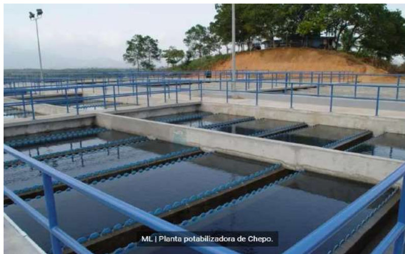
Fig. 19. Planta Potabilizadora de Chepo. Vista altura humana. @metrolibre. (2023, 12 de julio) https://www.metrolibre.com/nacionales/planta-potabilizadora-de-chepo-operara-al-50-este-jueves-YY4177742
