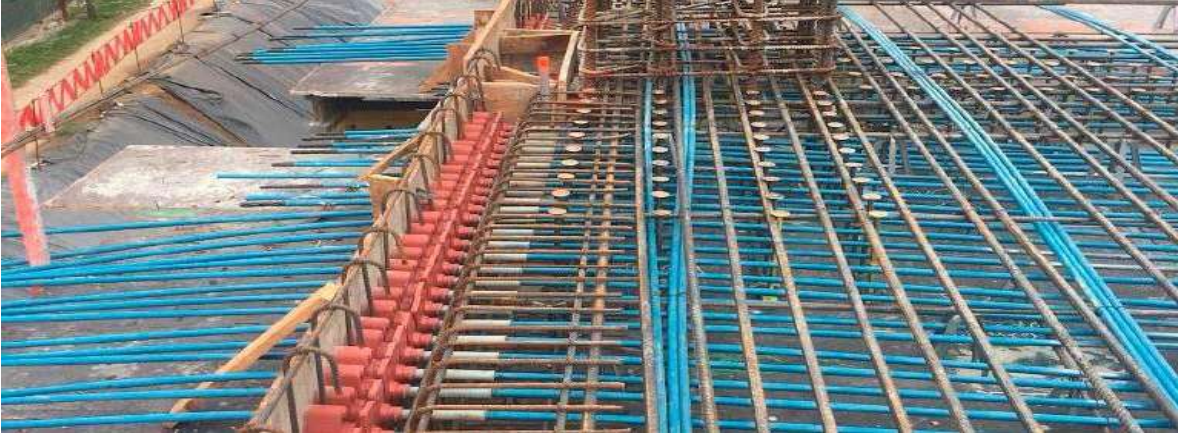
Figura 88. Estructura de losa postensada. Fuente: Pro-Mallas, 2019
