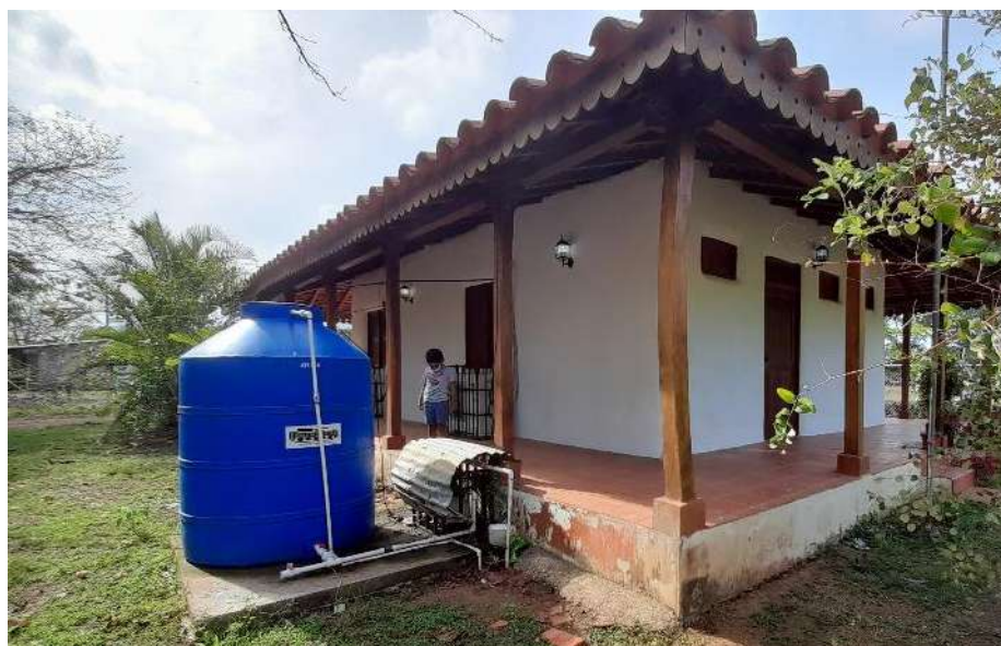
Imagen 17: Tanque de reserva. Fachada lateral derecha y posterior. Foto tomada el 29 de abril de 2022. [Realizado por autor]
