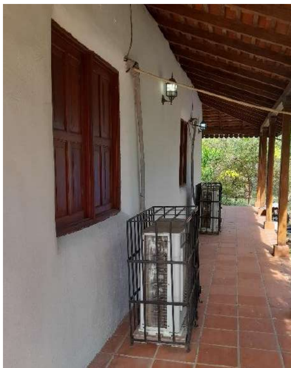
Imagen 16: Ventana de aire acondicionado. Fachada lateral derecha. Foto tomada el 29 de abril de 2022. [Realizado por autor]
