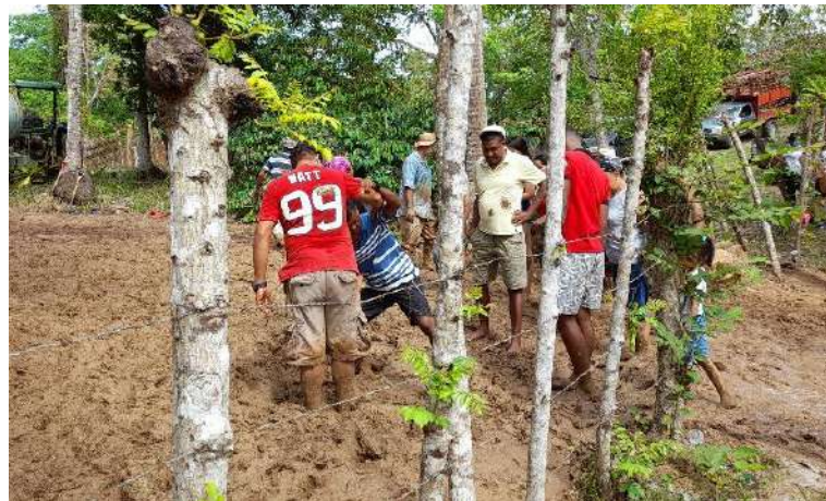
Imagen 24: Apisonamiento del barro. [Realizado por autor]
