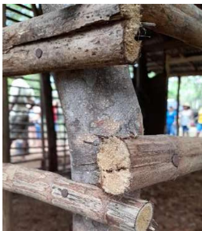
Imagen 25: Uniones atornilladas de la estructura. [Realizado por autor]
