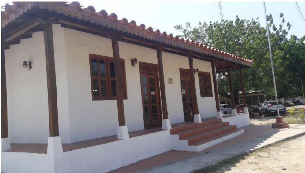
Imagen 31: Fachada frontal del TE de Tonosí. [Foto brindada por la Arq. Vanessa Arjona. Inspectora de Azuero. Dirección de Infraestructura]
