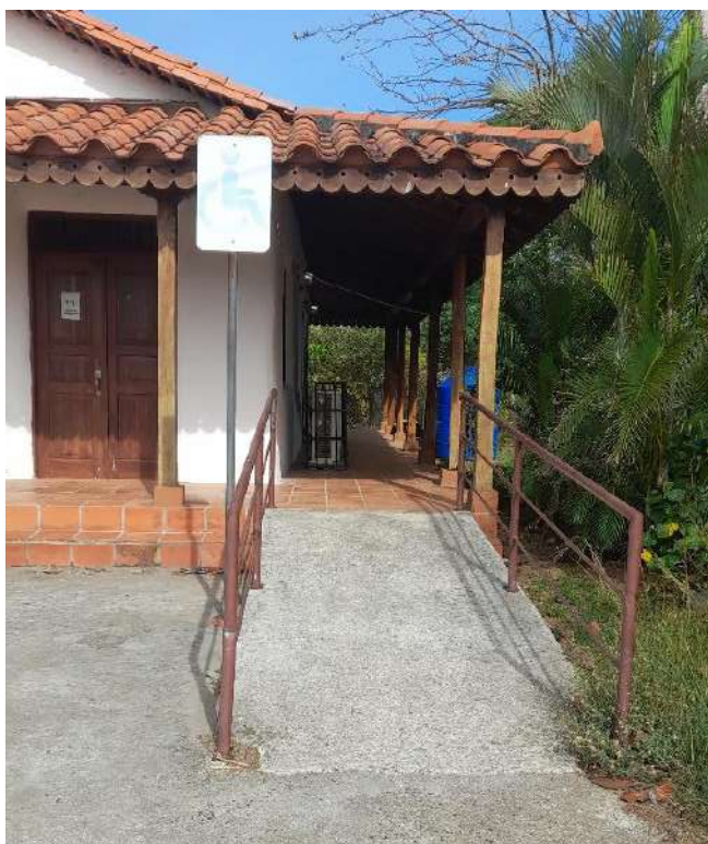
Imagen 12: Rampa para personas con movilidad reducida. Foto tomada el 29 de abril de 2022. [Realizado por autor Helen Arispe]
