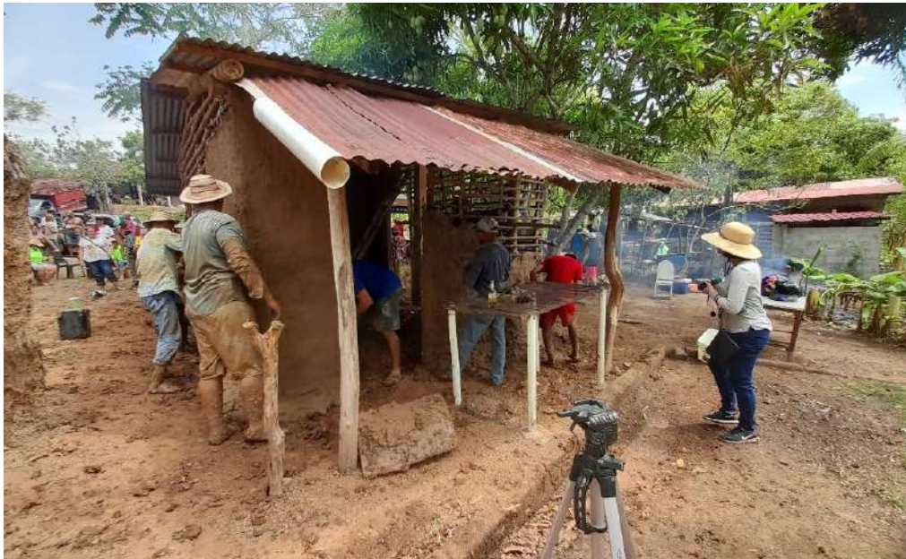
Imagen 29: Proceso de embarrado. [Realizado por autor]
