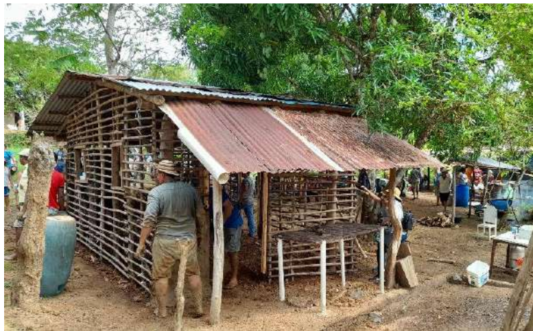
Imagen 23: Junta de embarre. Estructura principal, enjaulado y techo colocados. [Realizado por autor]
