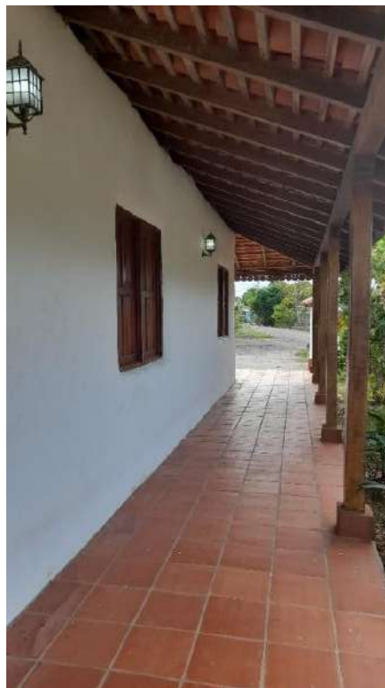
Imagen 15: Ventanas de fachada lateral izquierda. Foto tomada el 29 de abril de 2022.
