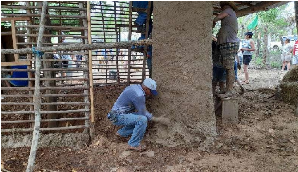
Imagen 28: Proceso de embarrado. [Realizado por autor]
