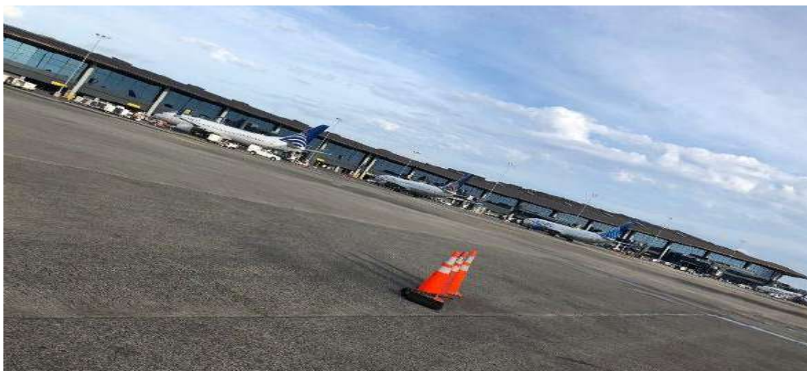
Imagen 51. Elaboración propia, Zona plataformas de embarques 201 hasta 210, Aeropuerto Internacional de Tocumen – 2024.
