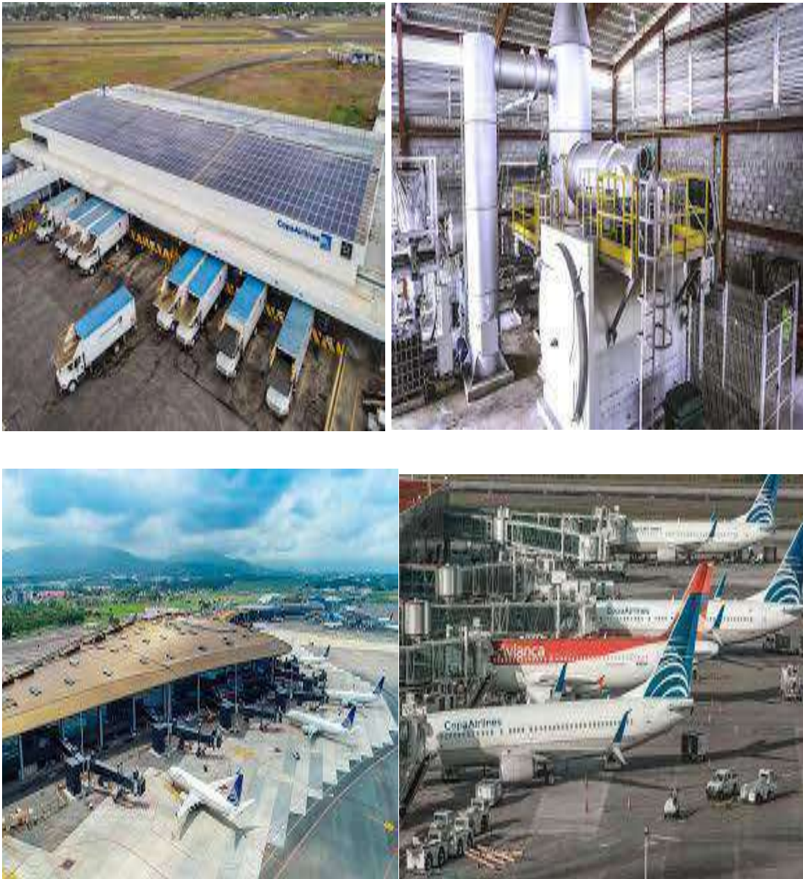
Imagen 42. Planta de Procesamiento de Residuos – Sistema de Paneles Solares – Optimización de recursos para movilidad de las aeronaves y encendido de motores - 2024
