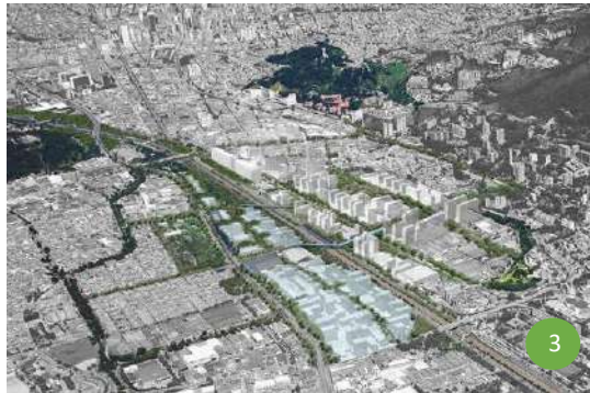
Imagen 2. Entre orillas. Parque y renovación urbana Medellín
