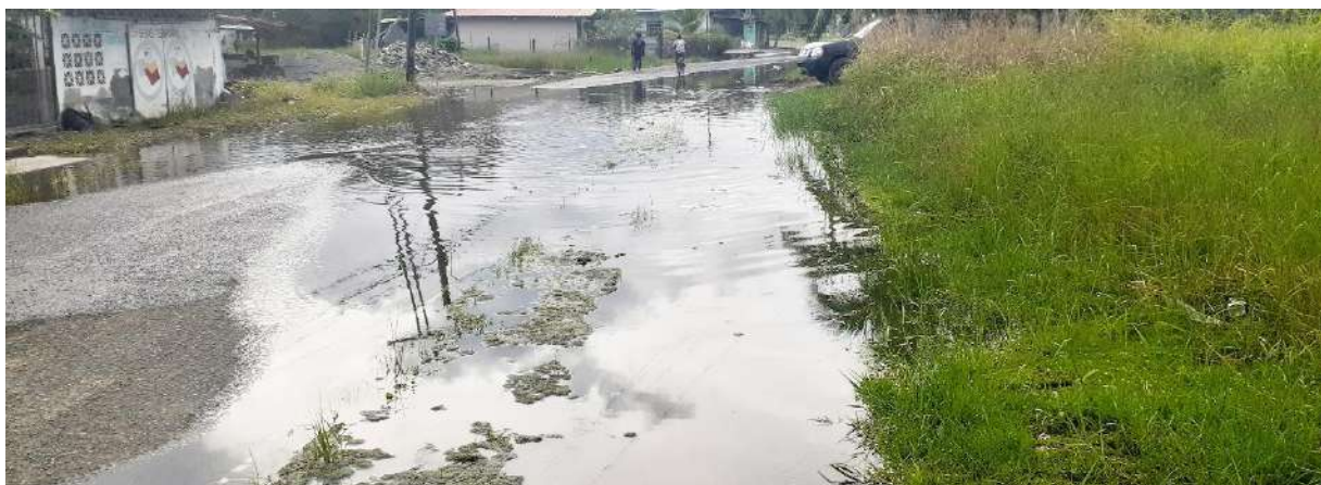
Img 78 Estado del canal de desagüe a un costado del terreno © Wilmer López (2021).
