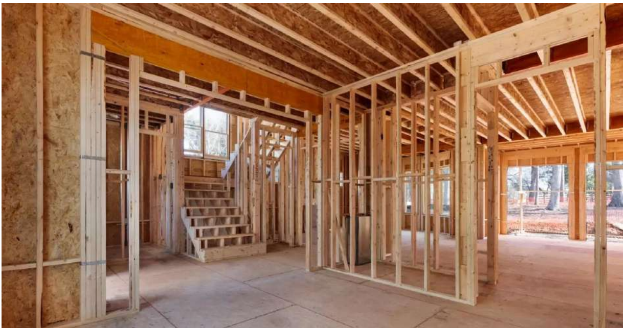
Img 86 Sistema Timber frame, interior de vivienda © David Papazian (s.f) shutterstock.com
