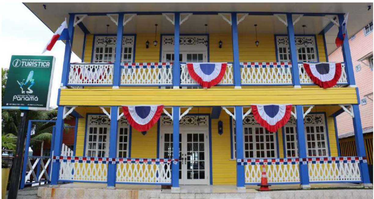
Img 64 Ventanas con lucetas y balcones con balaustres de madera © Omar Vargas (2019) twitter.com
