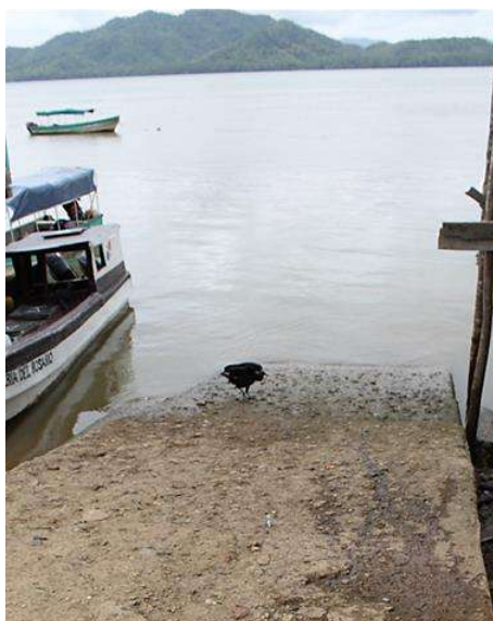
— Fig.13: Rampa de hormigón para la llegada de lanchas. 2022
