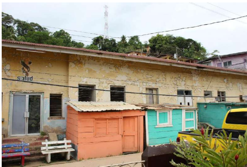
– Fig.6: Locales informales frente a edificio abandonado. 2022
