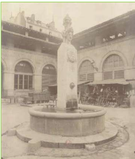
Imagen 8. Mercado de Les Carnes en 1898, antes de su demolición.
