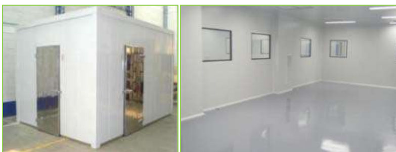
Imagen 94. Ejemplos de cuartos fríos y piso con acabado autonivelante. Fuente: www.its.com
