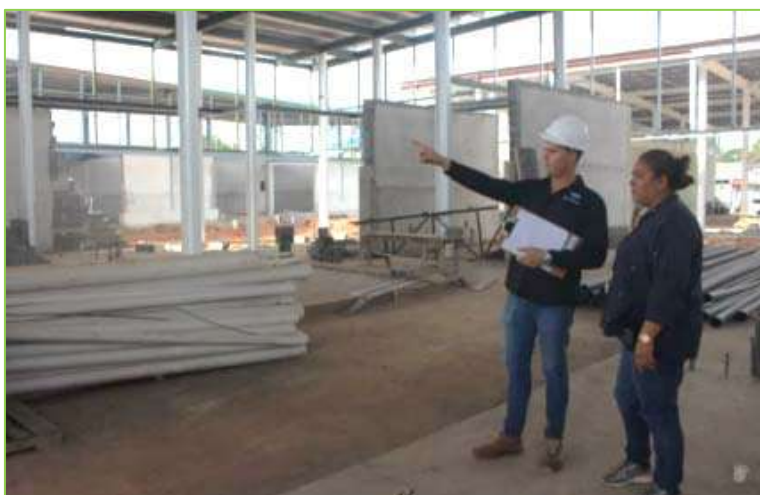
Imagen 35. Nuevo mercado en construcción. Fuente: www.cadenadefrio.com.pa/Recorrido-por-el-Mercado-Publico-y-el-Mercado-de-Abastos-de-La-Chorrera
