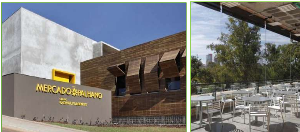
Imagen 26. Vistas del edificio Palhano.
