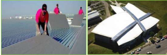
Imagen 82. Aislamientos térmicos y acústicos EPDM, TPO, PVC, y FleeceBACK. Fuente: www.Carlisle.com
