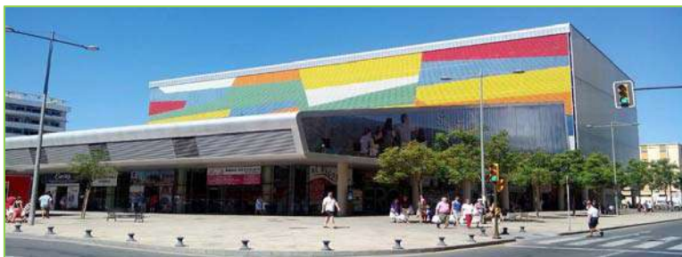
Imagen 21. Fachada principal del Mercado.
