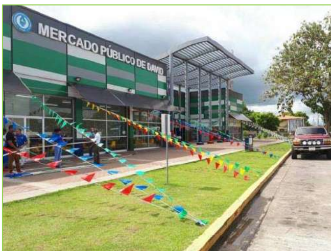
Imagen 27. Fachada del Mercado de David.
