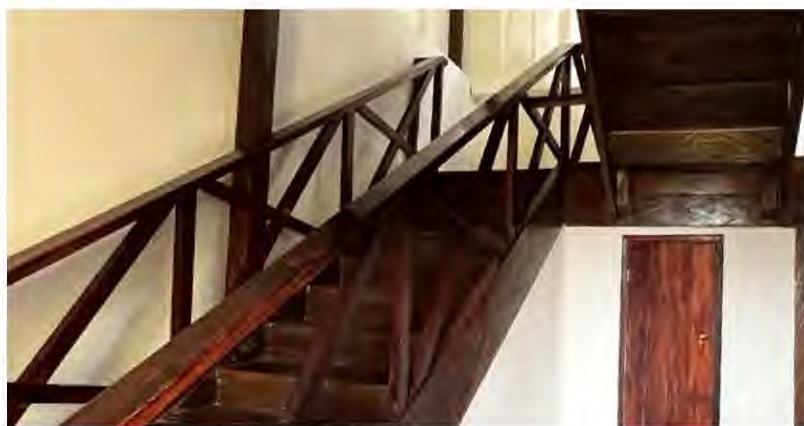
Figura 61 Escaleras internas de CEFATI. María Somoza, 2024.
