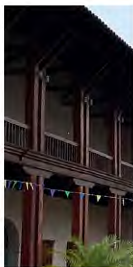
Figura 67 Fachada de Aduana. María Somoza, 2024.
