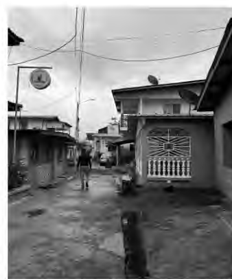
Figura 38 Vivienda Fuera de línea de propiedad. María Somoza, 2024
