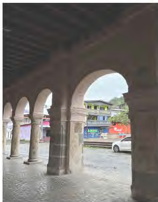
Figura 9 Pasillo dentro de la fachada frontal detrás de los arcos. María Somoza. 2024
