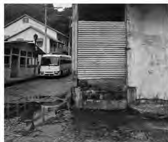
Figura 39 Edificio ocupando acera y rodadura. María Somoza, 2024
