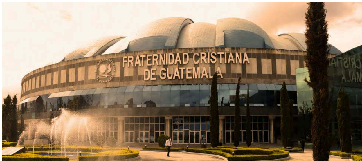
Figura 11. Fachada frontal del Mega Fráter.
