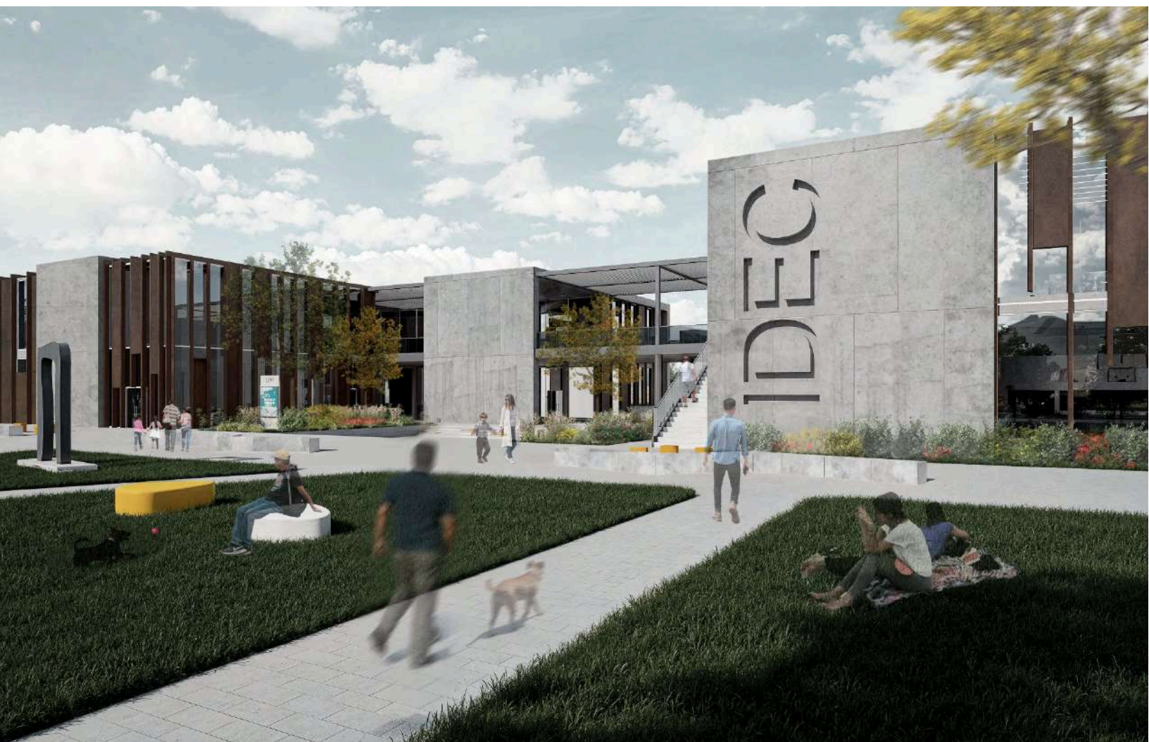
Figura 38. Vista frontal del Complejo IDEC. Elaborado por el autor.
