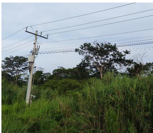
Ilustración 16 Poste de tendido eléctrico cercano al terreno
