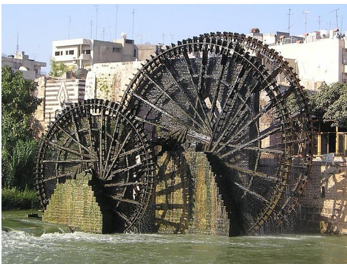
34 Norias Milenarias de Hama; Hama, Siria
