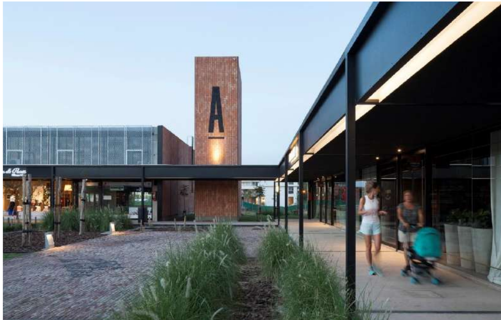
Figura 5 Centro comercial en Córdoba
