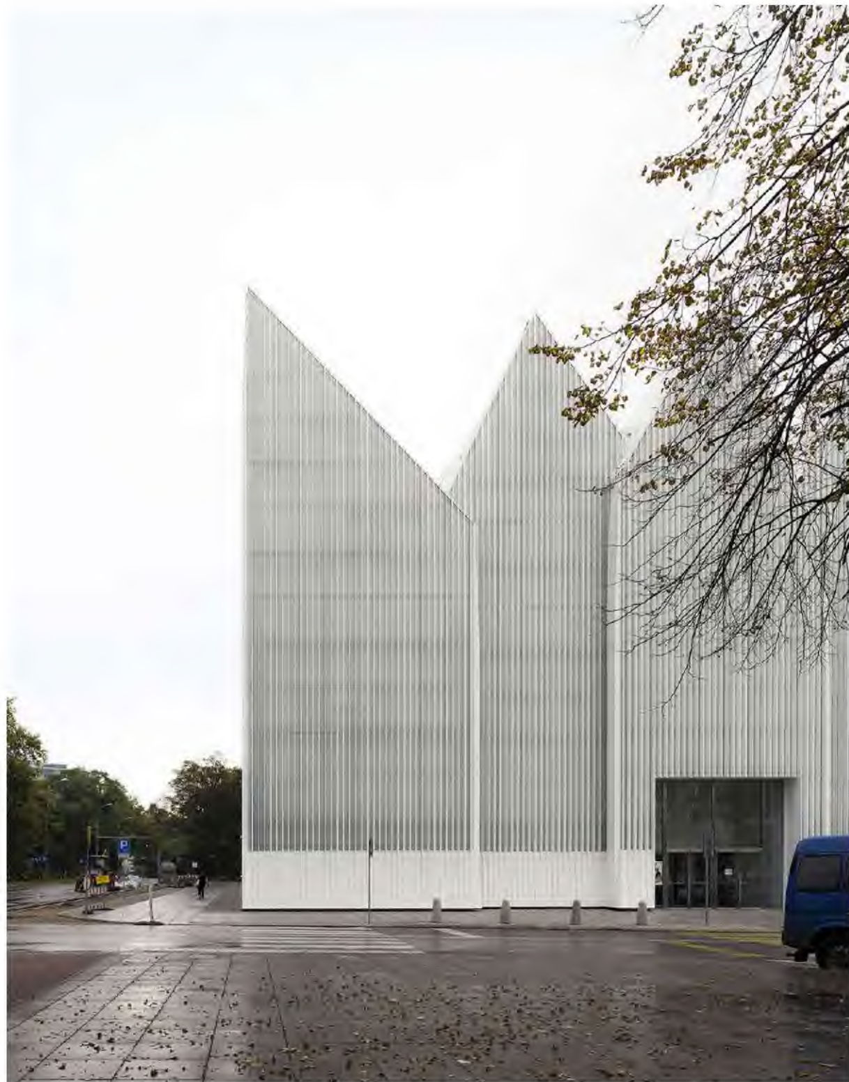
Imagen 1.41. Vista de la entrada principal de la filarmónica. Fotografía: © Simon Menges
