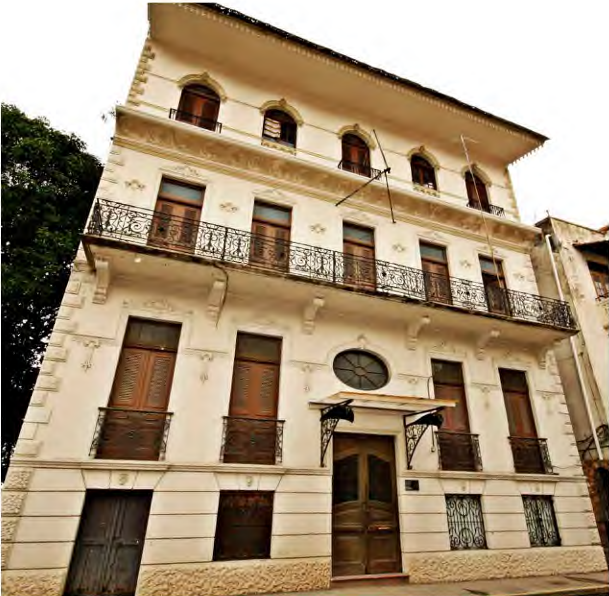
Imagen 1.61. Fachada del antiguo edificio del Conservatorio Nacional de Música de Panamá. San Felipe, Ciudad de Panamá Fotografía: © Isaías Montilla
