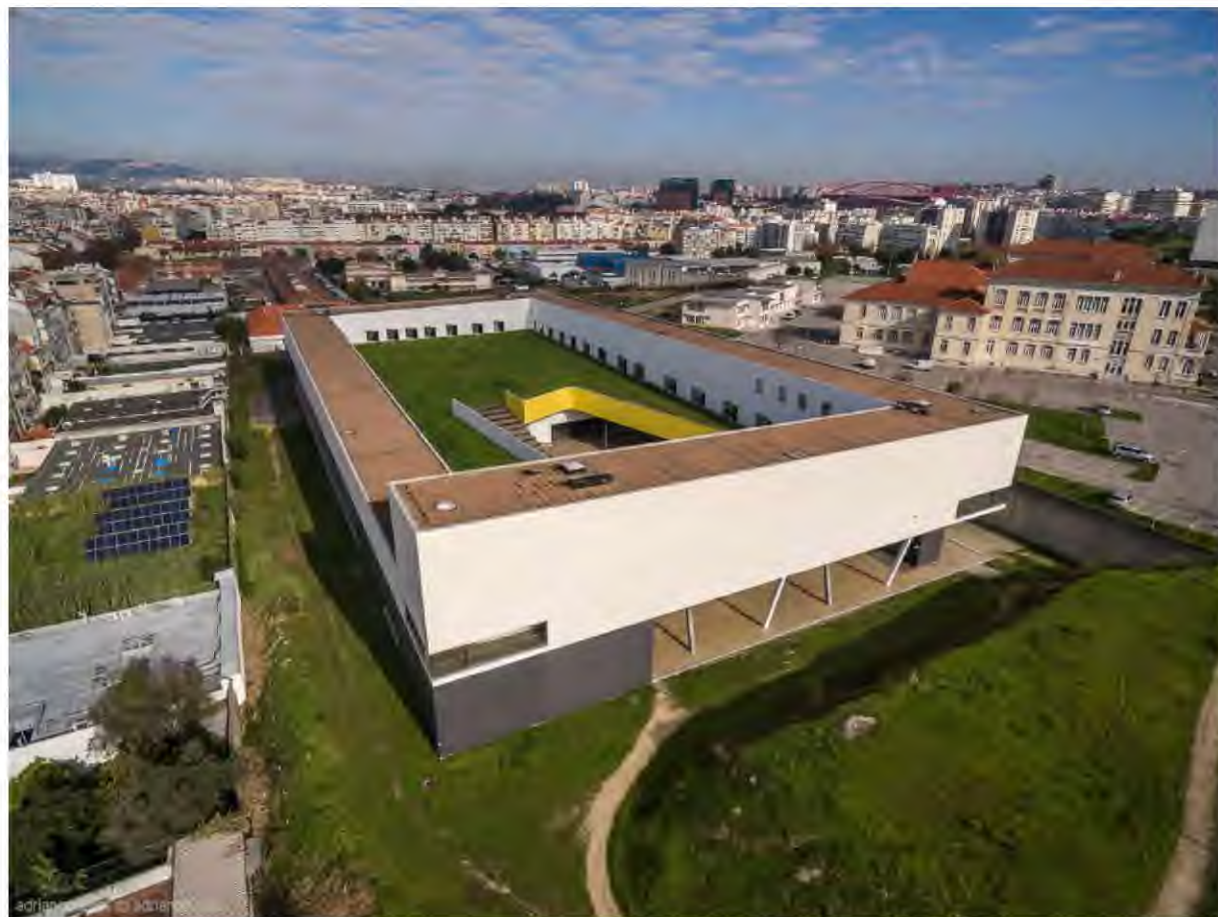
Imagen 1.30. Vista suroeste del edificio, cota más alta. Fotografía: © Adriano Neves
