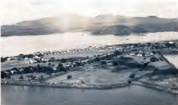
Imagen 1.76. Fotografía aérea del Fuerte Amador durante la época de la Zona del Canal. Fuente: Canal Zone Images (s.f.)
